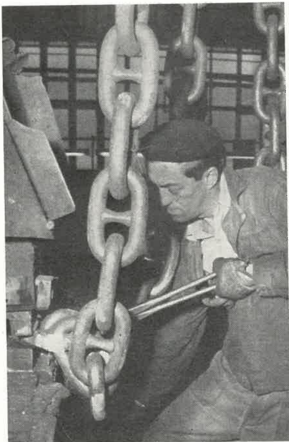
Sváření kotevnických řetězů
